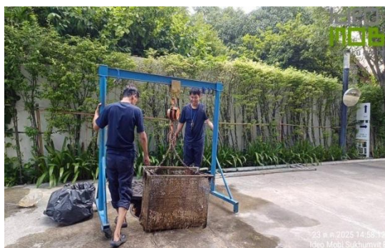
ภาพที่ 13 ตะแกรงดักขยะที่ Man Hole สุดท้าย
